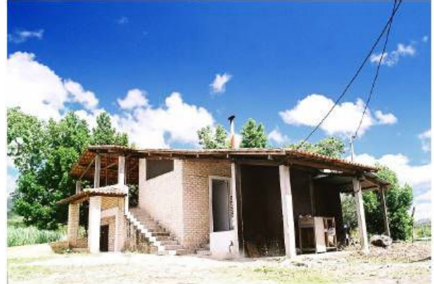
Figura 3.1.4.2: Instalação – Produtor formal FONTE: Agroindustrial BFLM Ltda.
